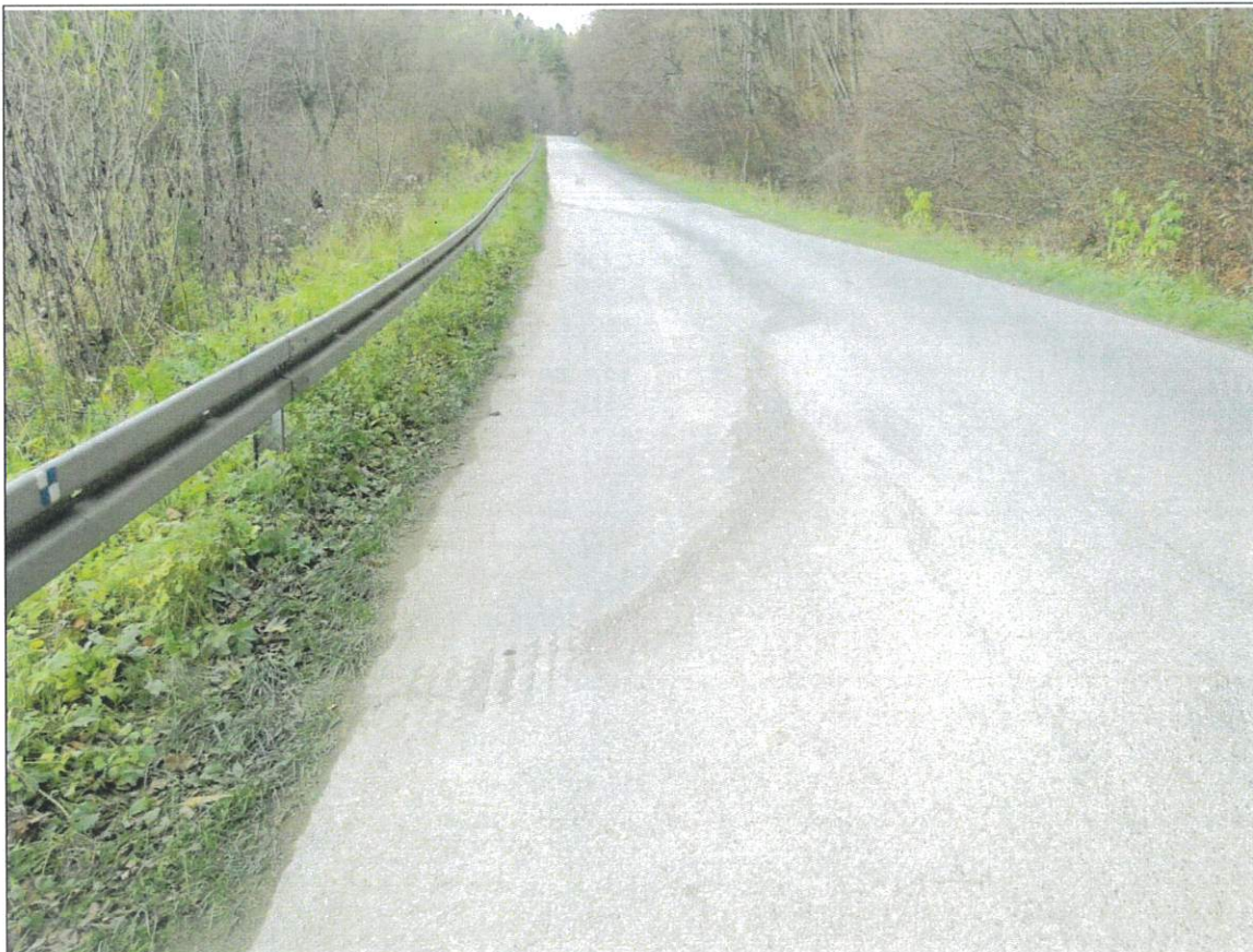
Widok na fragment naprawionej nawierzchni asfaltowej
